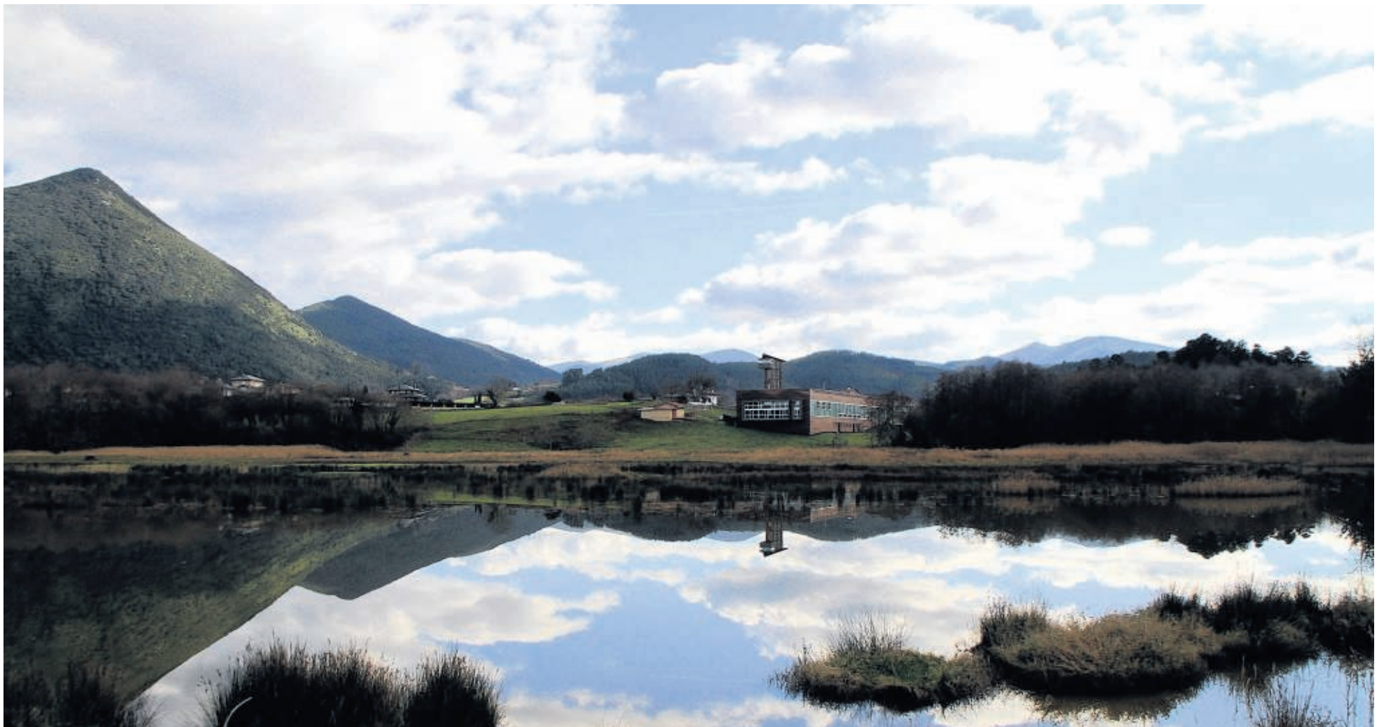
Het nieuwe vogelcentrum Urdaibai in Spaans Baskenland, met weerstation en uitkijktoren.
